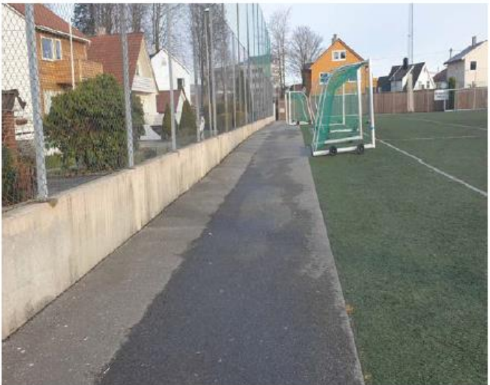
før/etter - kunstgress fram til kant rundt bane og over avløpskum som filter
