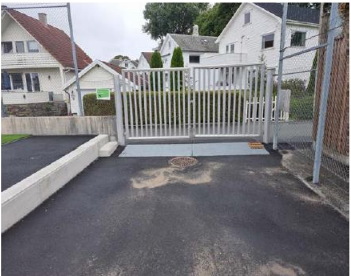
Vedlikeholdsport med rist, børste, kant, gangsluse, skilting og granulutfangsil i kum
