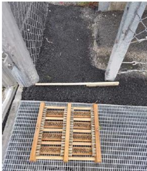
Vedlikeholdsport med rist, børste, kant, gangsluse, skilting og granulutfangsil i kum
