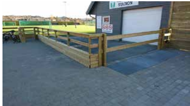
Kjøreport med kjøresterk rist for rengjøring av vedlikeholdsmaskin. Tangmoen, Stjørdaal. Foto: Tangmoen IL.
