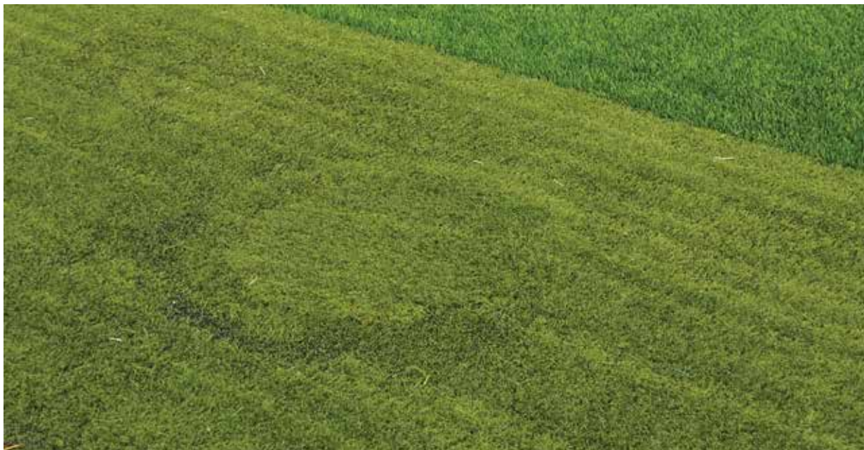
Overvannet filtreres gjennom sandinnfyllet i kunstgresset før det går til avløp. Moan stadion, Levanger Foto: NFF.
