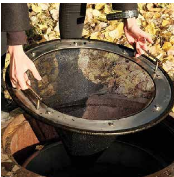
Granulatfangeren tas enkelt ut av kummen for rengjøring. Hvor ofte filteret må rengjøres, avhenger av kummens plassering. Foto: Miljøbaner
