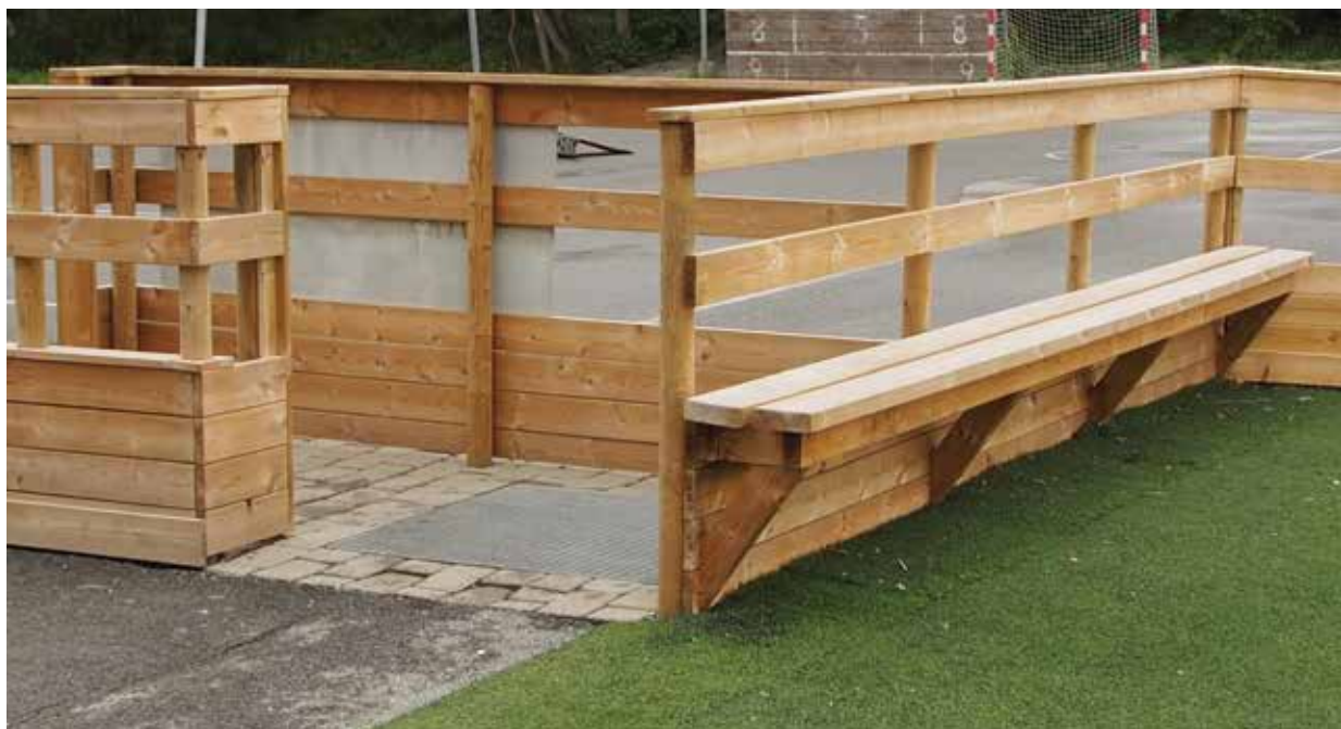
Sluse med granulaterfanger bygget av klubb på dugnad. Granulat samles opp på underliggende kunstgress og i fotrist. Vannet infiltreres i baneoppbyggingen. En effektiv og billig løsning. Tangmoen, Stjørdal. Foto: NFF.
