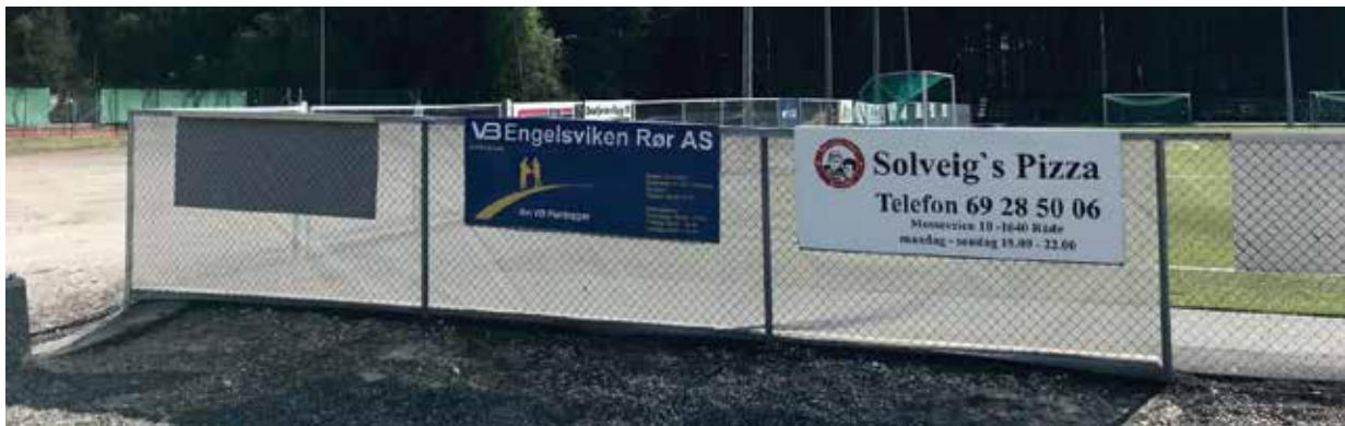
Barriereduk montert på flettverksgjerde, Råde. Foto: Hansen Protection.
